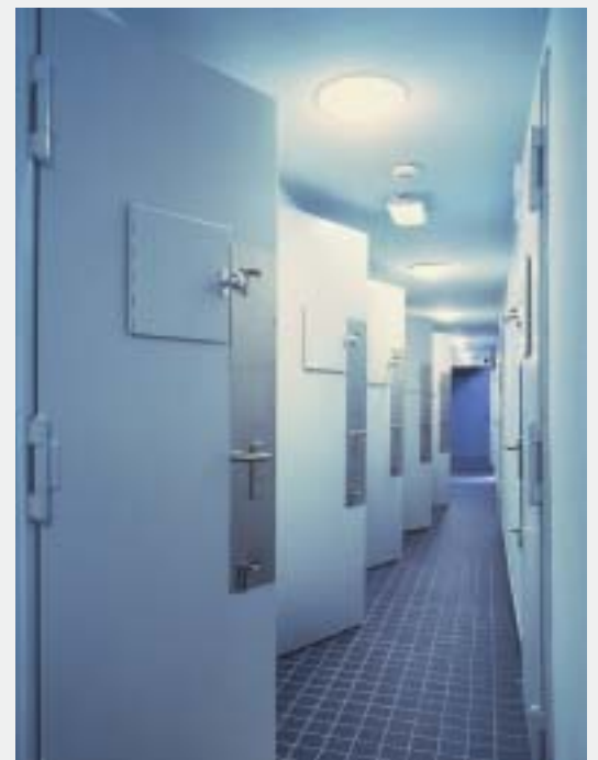
Zellengewahrsamstür mit Abdeckklappe des Sichtfensters.
