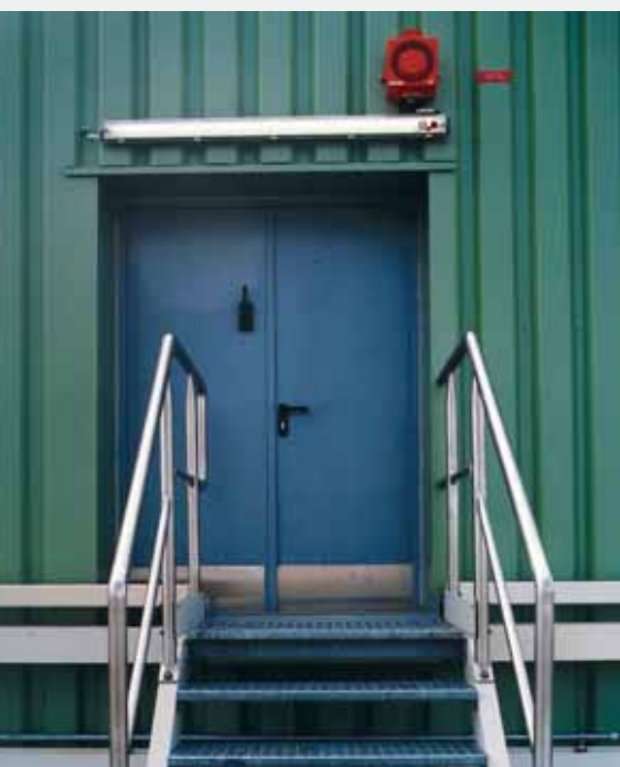
dw 42-2 „Teckentrup“ mit Stoßplatten im Bodenbereich.
