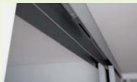
Auf Maß gefertigt: Die obere Führungsschiene verläuft an der Decke.
